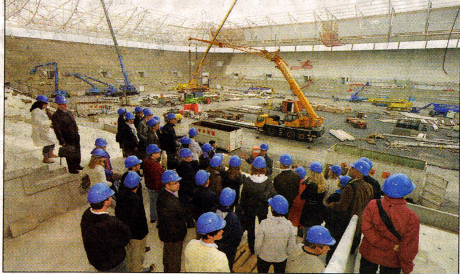
Auch im Innenbereich der Rhein-Neckar Arena laufen die Arbeiten auf Hochtouren.
